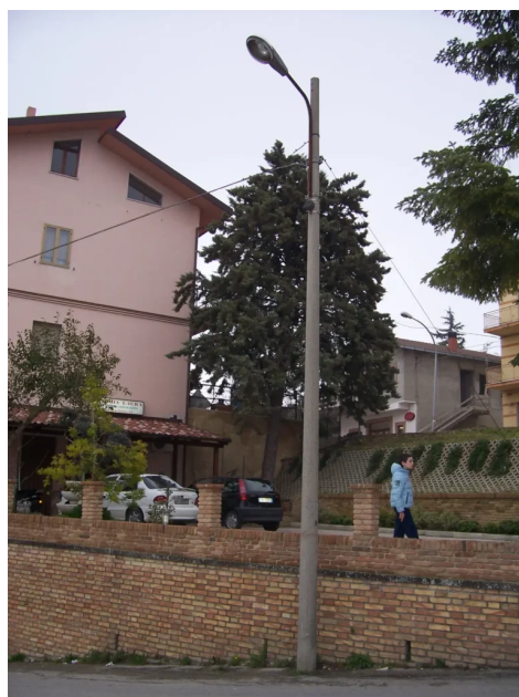
Atessa pre interventi
